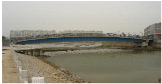
图3 建成的东营桥
